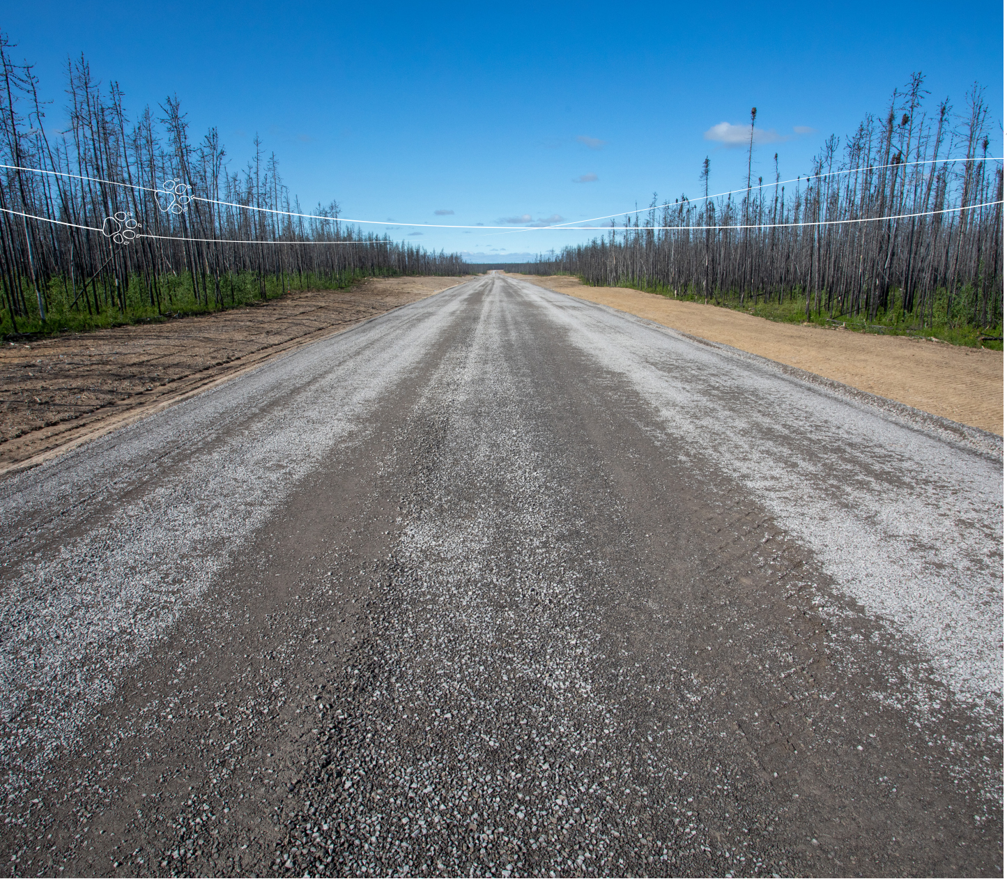
Section de la route des Tłı̄ch̄o presque terminée
