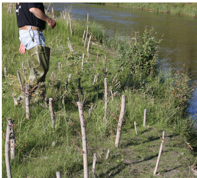
figure 30. Des plants de saule peuvent aider à maîtriser l'érosion dans les secteurs sensibles, comme les zones riveraines.
