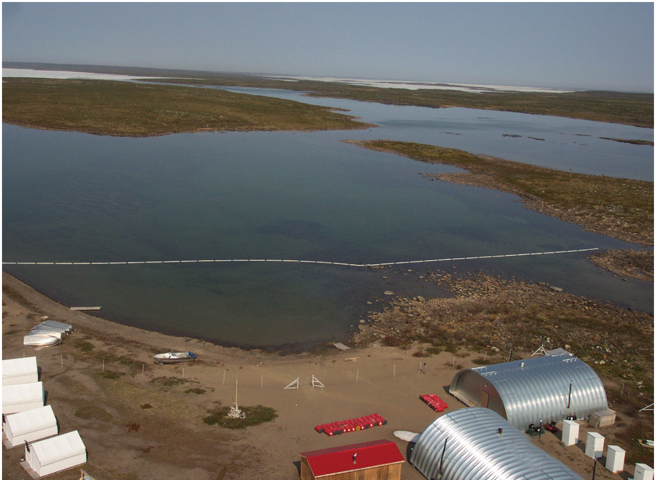
figure 25. Une trousse d'intervention en cas de déversement doit comprendre des estacades absorbantes, pour confiner les déversements en milieu aquatique.
