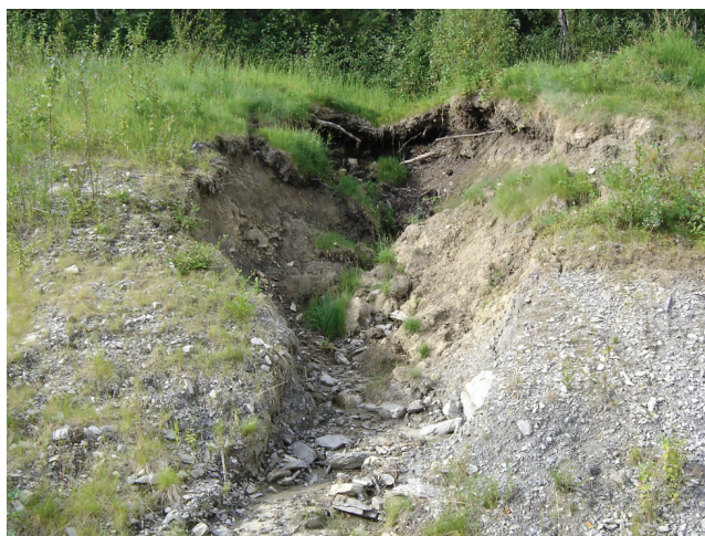
figure 27. Les sites remis en état doivent être stables et libres d'entretien. À cet endroit, il faudra aménager de meilleurs ouvrages de régulation du drainage pour contrer l'érosion.
