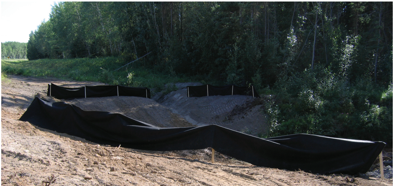
figure 17. Rideaux à sédiments servant à réguler le drainage à l'orée d'une zone défrichée.
