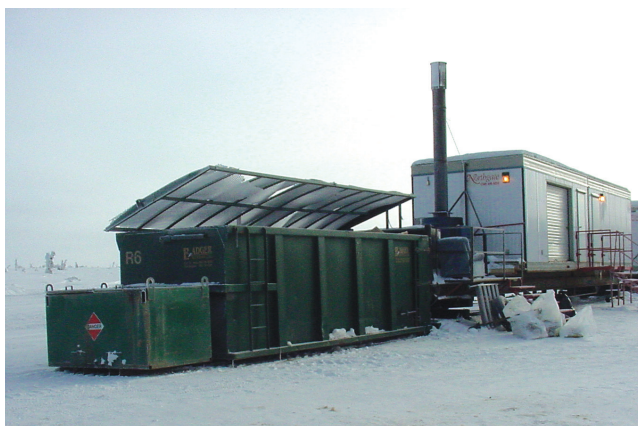
figure 20. Incinérateur alimenté par combustible, avec un conteneur situé à proximité pour stocker les déchets non combustibles.
