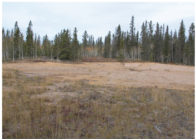
figure 23. Le site de la carrière a été nivelé pour lui donner son relief d'origine, puis laissé à reverdir naturellement.
