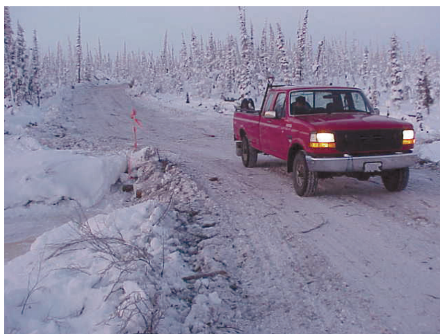
figure 10. (haut) La tranchée de drainage sert à diriger l'eau vers un bassin de décantation à l'intérieur de la fosse.
