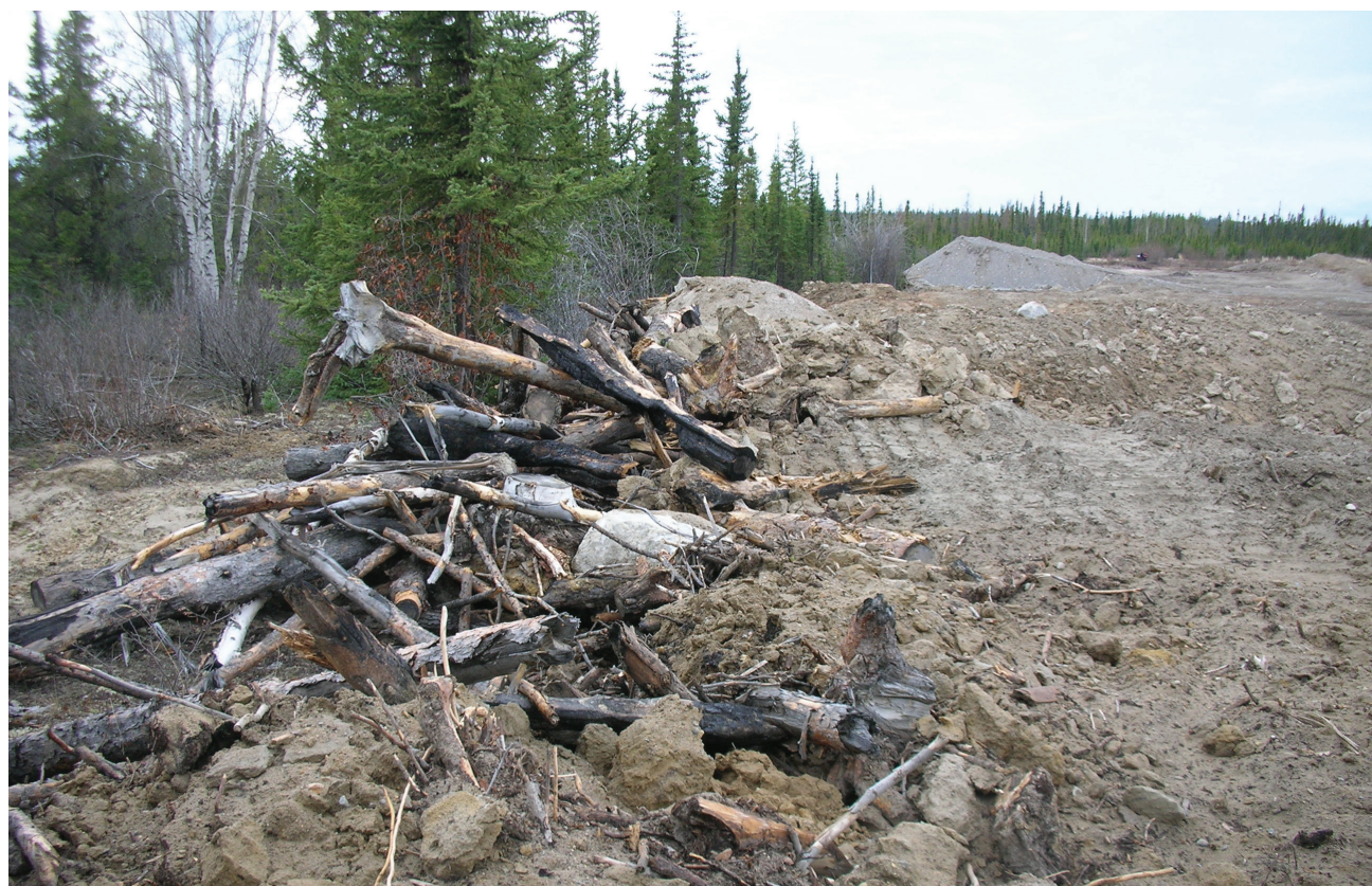
figure 20. Il est conseillé de ne pas mélanger les morts-terrains et les débris ligneux, et de les empiler à au moins 5 m des arbres sur pied.
