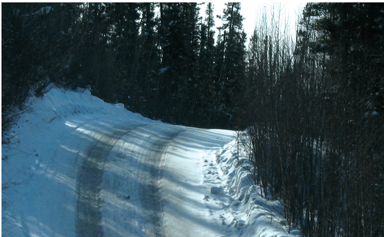
figure 12. Il convient de concevoir les pentes et les courbes des routes pour qu'elles soient sûres et permettent de réduire au minimum la perturbation du milieu. Ainsi, une courbe plus large et une pente moins abrupte seraient plus sûres et moins favorables à l'érosion.
