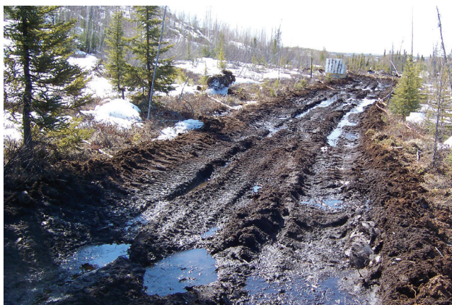
figure 15. L'établissement d'un calendrier adéquat pour la construction de la route permet d'éviter l'orniérage et l'érosion.
