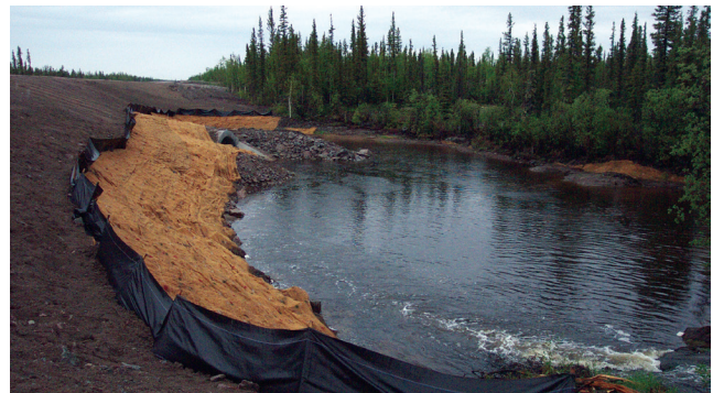
figure 28. Des clôtures et des matelas anti-érosion peuvent être utilisés pour réduire l'érosion à proximité des étendues d'eau.
