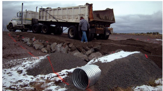
figure 26. Ce drain transversal est recouvert de matériaux granulaires à grain grossier qui assurent une protection contre le gel.
