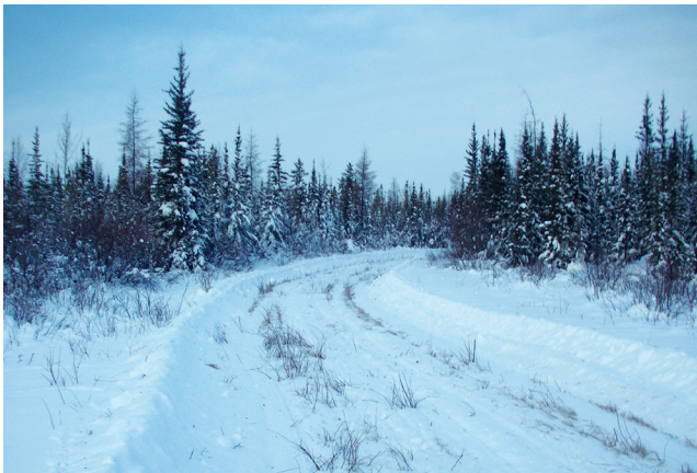
figure 37. Les routes d'hiver ne peuvent pas être empruntées par des véhicules à roues lourds tant qu'elles ne sont pas recouvertes d'au moins 10 cm de neige compactée. L'herbe qu'on peut voir sur cette route indique que l'épaisseur de la neige est inférieure à 10 cm.
