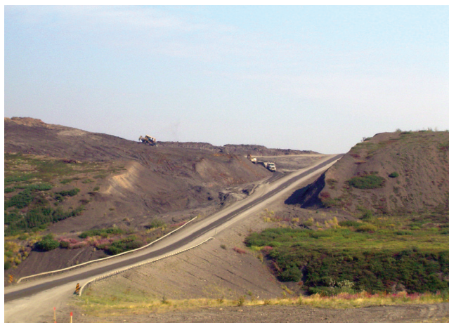
figure 22. On a réduit la pente de cette route à l'aide des déblais provenant de l'excavation adjacente.
