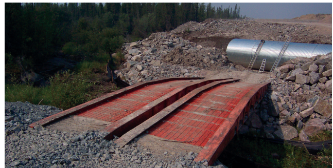
figure 31. Des ponceaux de taille inadéquate risquent de provoquer une érosion et d'endommager la route.
