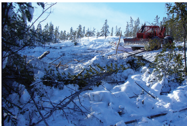
figure 17. Les broussailles peuvent être renversées à l'aide d'un bouteur.
