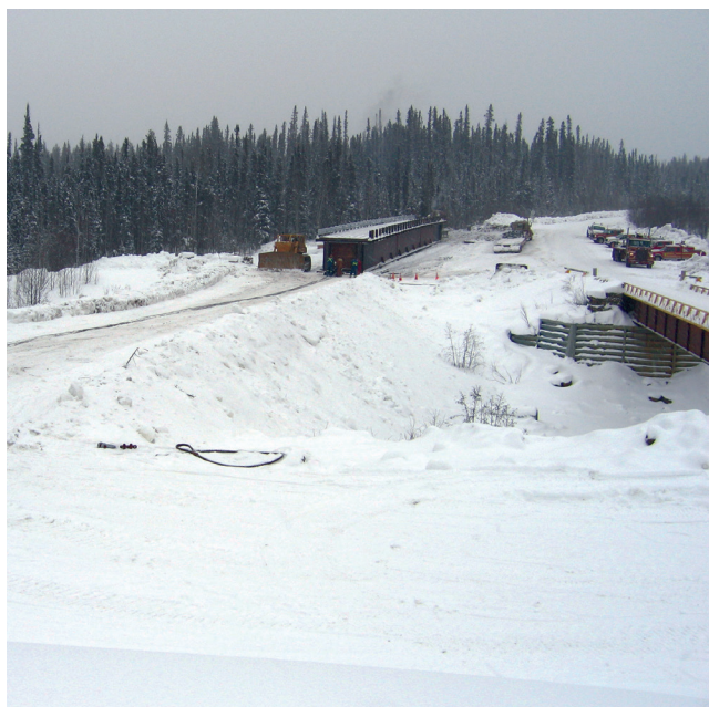
figure 39. Remblai de neige bien aménagé adjacent à un nouveau pont.
