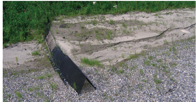
figure 27. Des blocs de fossé et des végétaux peuvent être utilisés pour ralentir le déplacement des sédiments dans les fossés qui sont parallèles à la route.
