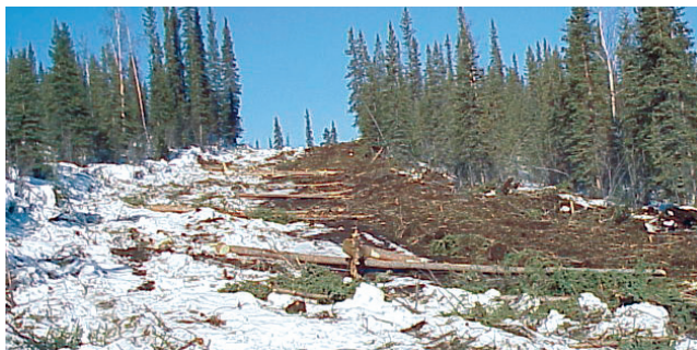
figure 20. On peut se servir des broussailles comme collecteur de sédiments sur les talus abrupts.
