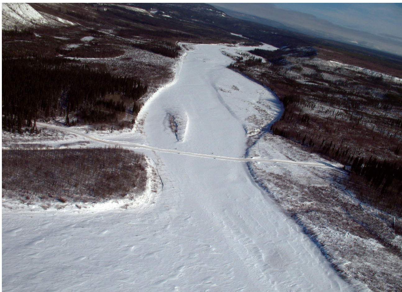
figure 41. Pont de glace construit sur un grand cours d'eau.
