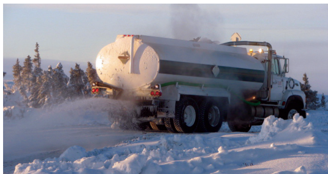
figure 36. On peut réaliser la surface de la route en glace, à l'aide d'un camion-citerne doté d'un pulvérisateur.
