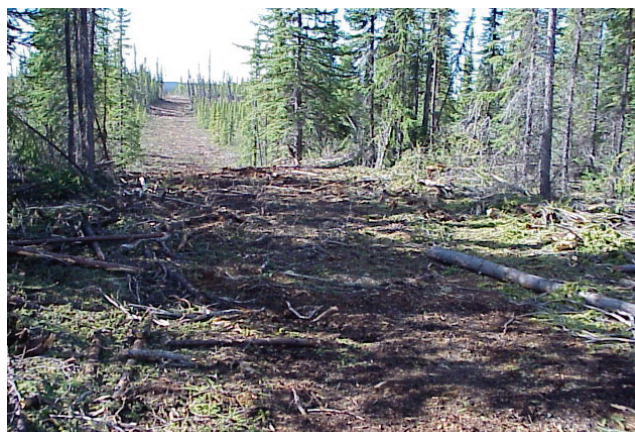
figure 16. Ne défricher que la largeur minimale nécessaire pour la route.
