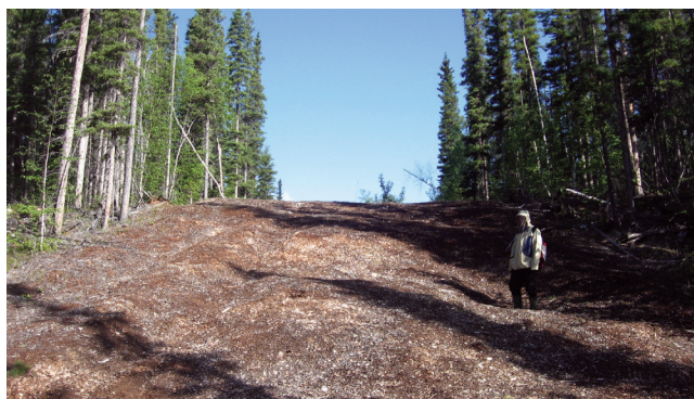
figure 46. Un tassement différentiel peut se produire dans un terrain de pergélisol comportant beaucoup de glace.
