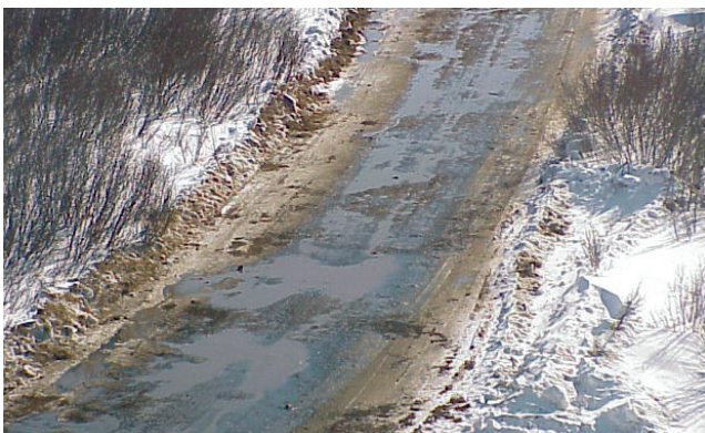
figure 38. Les flaques d'eau et le manque de neige indiquent que le sol dégèle et que cette route d'hiver doit être fermée immédiatement.
