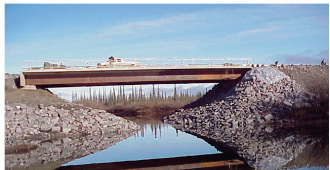
figure 33. Un pont portatif est la méthode de passage de cours d'eau qui convient le mieux aux routes d'accès temporaires.
