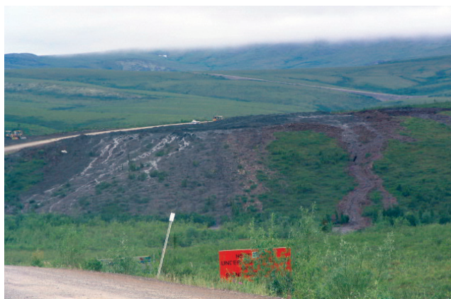
figure 45. Une surveillance périodique permet de repérer les endroits où la régulation du drainage ne convient pas et doit être revue.
