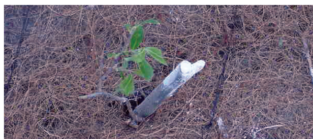
figure 51. Pour réduire l'érosion, on peut notamment avoir recours à des matelas anti-érosion et planter des boutures de saule.
