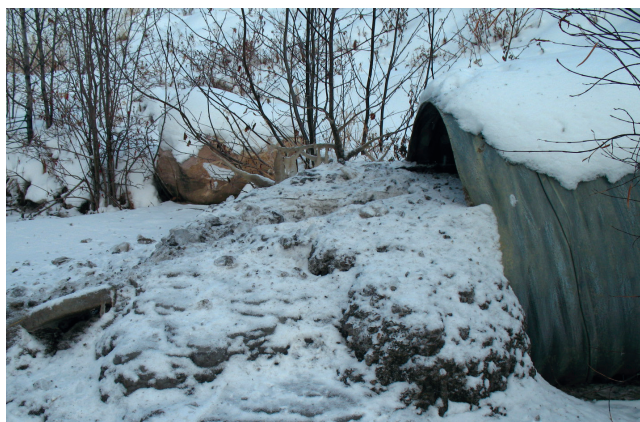
figure 44. Les ponceaux doivent être surveillés et nettoyés périodiquement de sorte qu'ils s'acquittent adéquatement de leur fonction.
