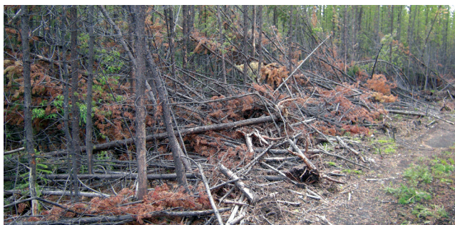
figure 21. Enlèvement inadéquat des broussailles dans la végétation forestière. On doit couper les arbres penchés et disposer les broussailles en andains.
