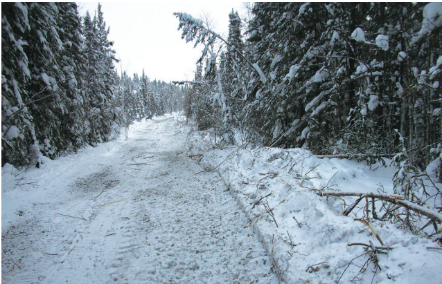
figure 25. Les arbres inclinés se trouvant sur cette ligne sismique récemment défrichée doivent être enlevés et il faut davantage de neige ou de glace pour protéger la surface du sol.
