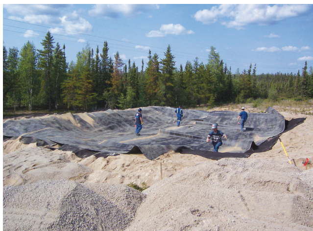
figure 38. On peut utiliser une aire munie d'un revêtement et de bermes appropriées comme aire de confinement secondaire pour le stockage de combustible.
