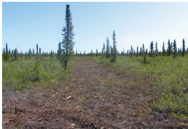
figure 31. Ligne sismique dont l'aménagement remonte à un an où l'on a utilisé la technique de transformation en paillage et d'épandage de celui-ci pour l'enlèvement des broussailles.
