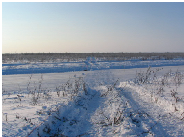
figure 10. Cet ouvrage de franchissement de cours d'eau bien placé est situé à angle droit par rapport à la berge et réduit la perturbation de la zone riveraine.
