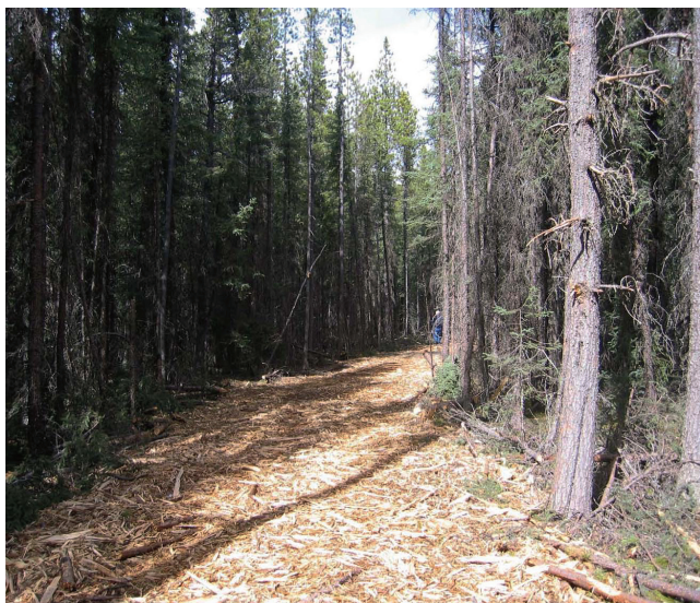
figure 16. Voici un bon exemple de ligne sismique étroite sinueuse. Les broussailles enlevées ont été transformées en paillage et ont ensuite été épandues sur la ligne. Photographie gracieusement offerte par Explor.
