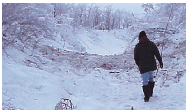
figure 12. Le remplissage de neige doit être effectué au moyen de glace ou de neige propre, de manière à créer une surface égale d'une berge à l'autre. Ce remplissage de neige aurait dû être réalisé à l'aide de matière propre et de manière à créer des pentes plus graduelles.
