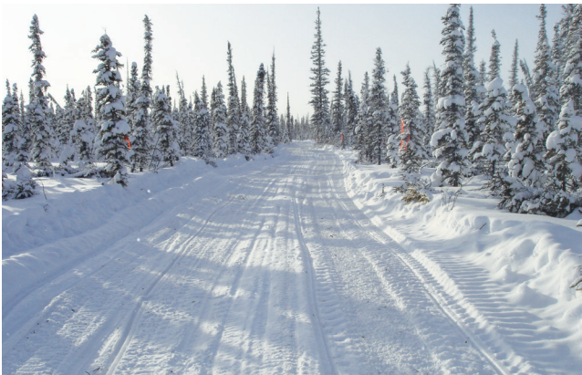
figure 26. Voici une ligne sismique acceptable ne comportant aucun arbre incliné et qui est recouverte d’une quantité suffisante de neige tassée.
