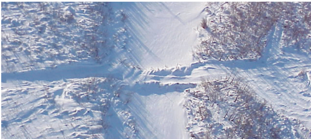
figure 11. On aurait pu procéder au remplissage de neige à l'emplacement de cet ouvrage de franchissement de cours d'eau afin de réduire la hauteur de la berge et le risque d'érosion lorsqu'il n'y a pas de glace.
