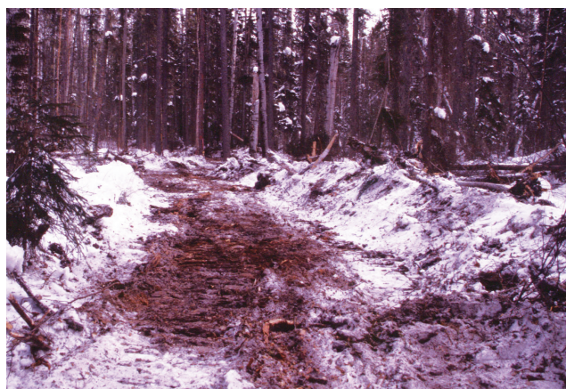
figure 33. Sur cette ligne sismique, les broussailles sont mises en andains, mais les arbres debout se trouvant dans les amoncellements doivent être coupés. Il faut davantage de neige ou de glace pour protéger la surface du sol.
