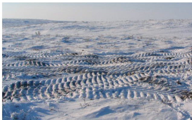
figure 23. La présence de terre mélangée à la neige indique que les travaux exécutés sur ce site ont débuté sans que la couche de neige soit suffisante pour protéger la surface du sol.
