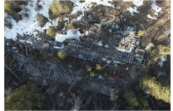
Photo 3 : Station de pompage
