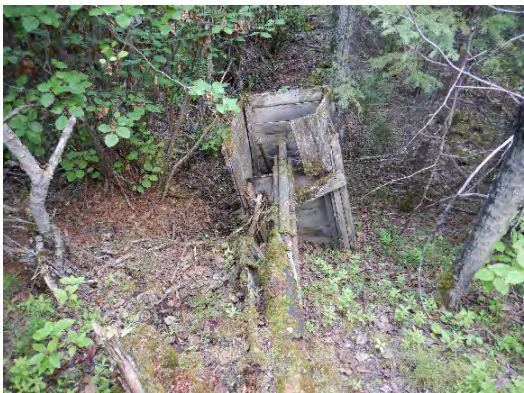
Photo 1 : Utilidor au mille 0 à 1
