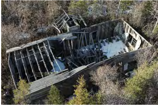
Photo 1 : Bâtiment des bains
